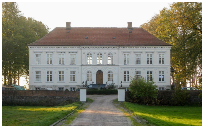
Bild 17. Rydebäcks nuvarande huvudbyggnad är byggd kring 1855 under Carl Hoftreters tid.
